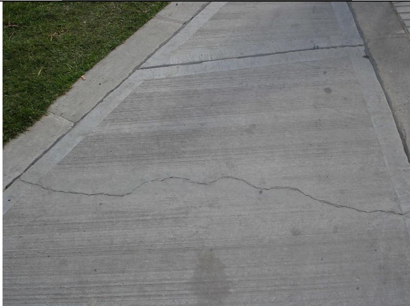
No se observa demarcación realizada en esta intersección, se evidencian obras de recuperación de la carpeta asfáltica. En los andenes concreto se presentan fisuras que deterioran las obras ejecutadas por el contratista
