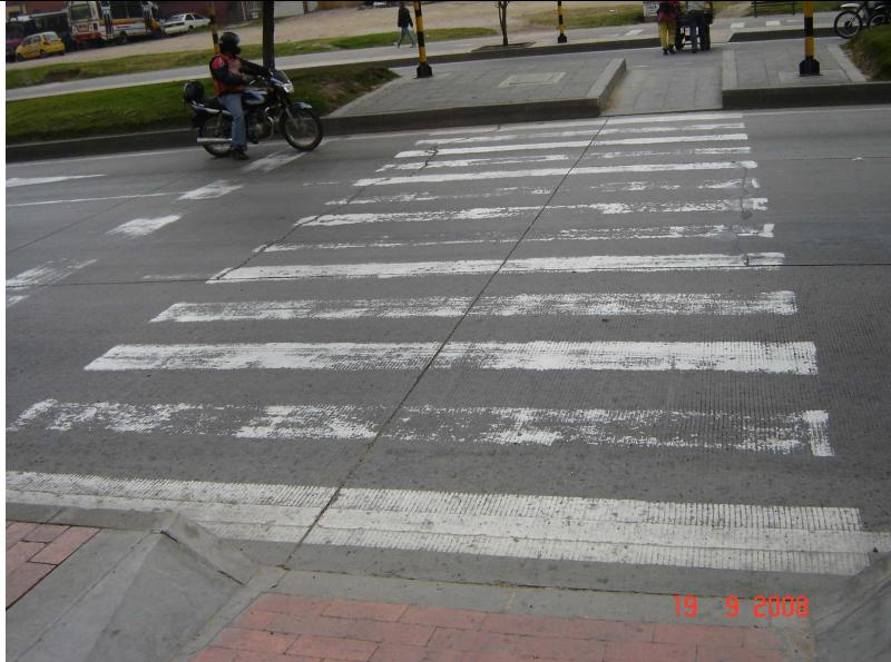
Se observa el estado de la intersección, en donde la demarcación realizada ha comenzado a deteriorarse, en 12 meses de funcionamiento.
