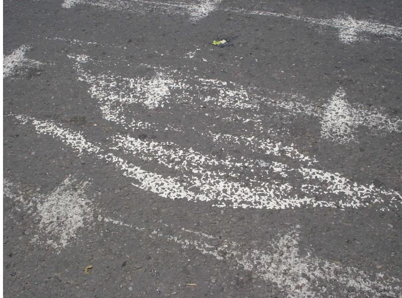
Se observa el estado de la intersección, en donde la demarcación realizada ha comenzado a deteriorarse, en solo 9 meses de funcionamiento.
