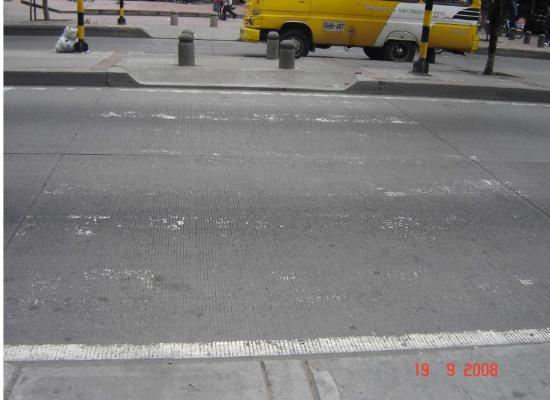
Se observa el estado de la intersección, en donde la demarcación realizada ha comenzado a deteriorarse, en solo 8 meses de funcionamiento.
