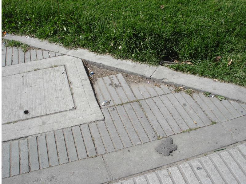
Se presentan hundimientos en los andenes construidos en tabletas que deterioran las obras ejecutadas por el contratista.
