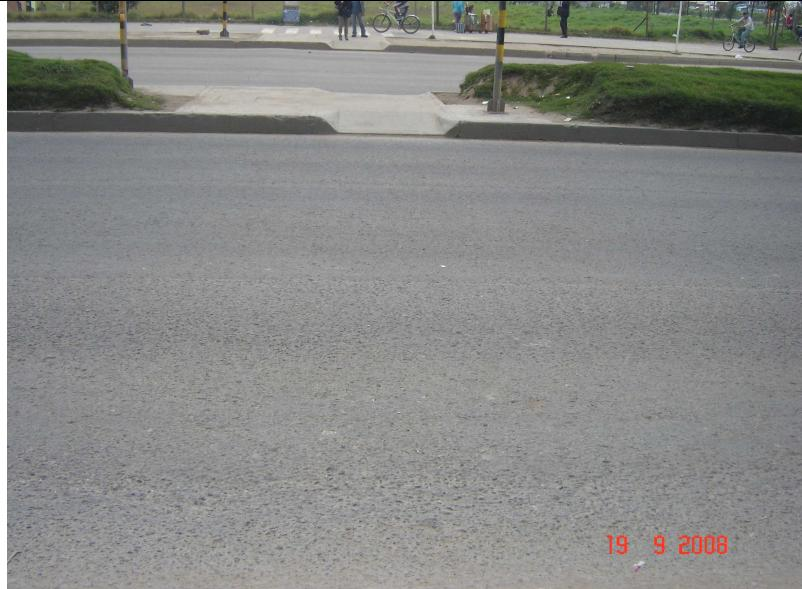
Se observa el estado de la intersección, en donde la demarcación realizada ha desaparecido totalmente, en solo 13 meses de funcionamiento
